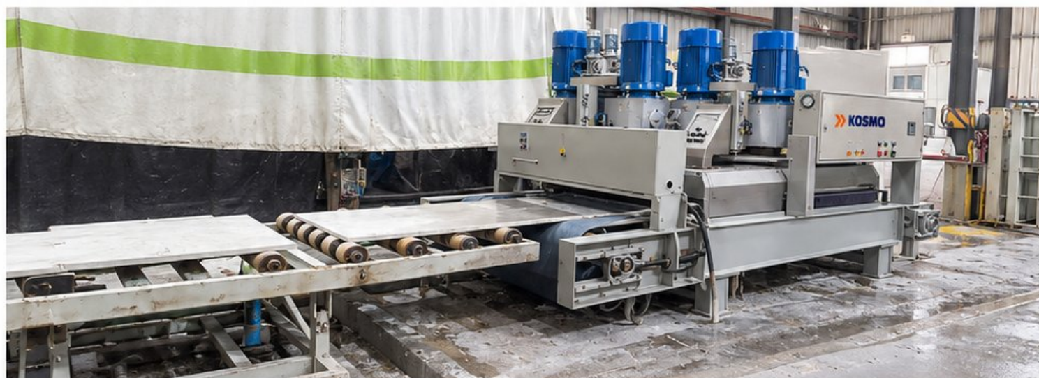
Instalação da calibradora contínua.
